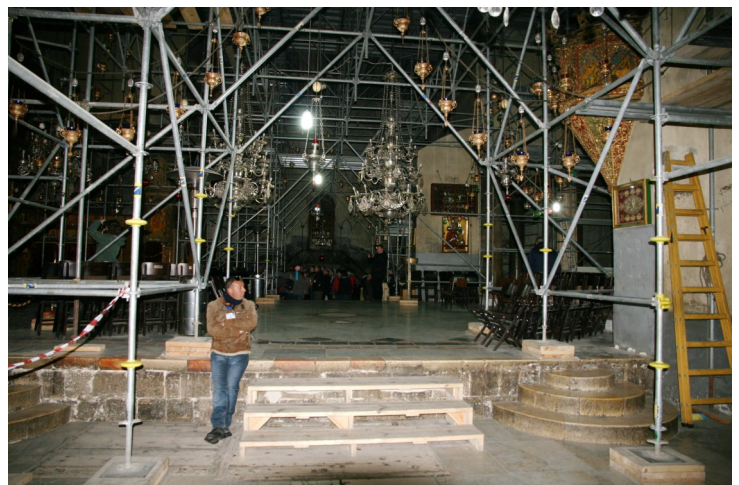
Die Geburtskirche wird derzeit einer Innenrenovierung unterzogen.
