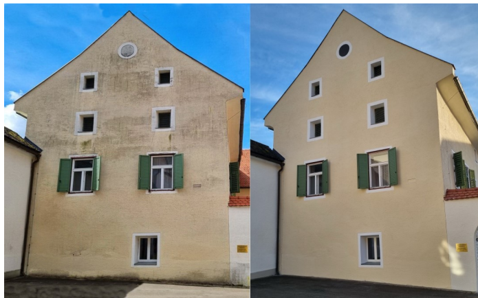
Fassade des Pfarrhofes Oberwölz
